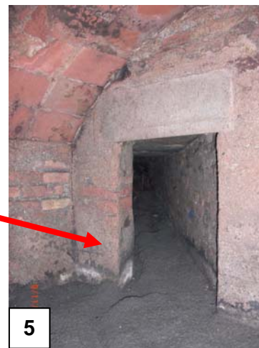
Imatge:Interior col·lector, al costat esquerra es pot veure l'obertura corresponent a la canalització que desguassa. Imatge dreta: detall obertura canal de desguàs al col·lector. Autora: Marta Maragall
