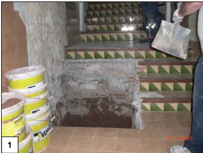
Imatge: localització i ubicació de la fossa per a la caixa d'ascensor just en l'inici de les escales que duen als pisos superiors.
