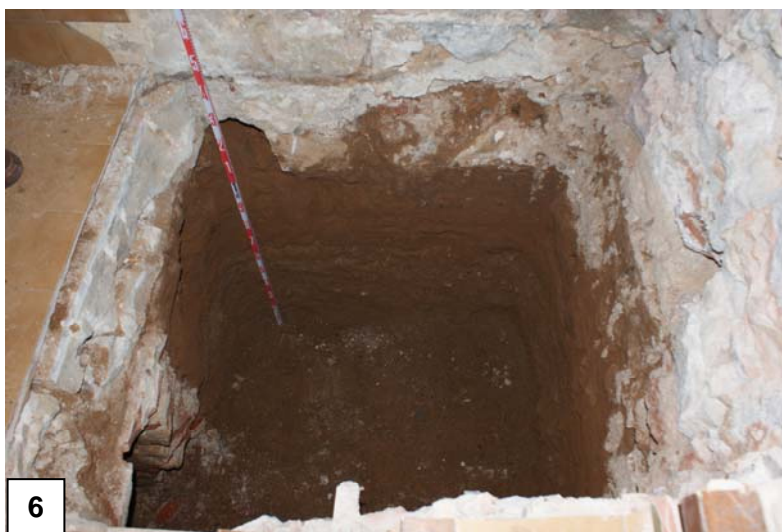
Imatge:Interior col·lector, al costat esquerra es pot veure l'obertura corresponent a la canalització que desguassa. Imatge dreta: detall obertura canal de desguàs al col·lector. Autora: Marta Maragall
