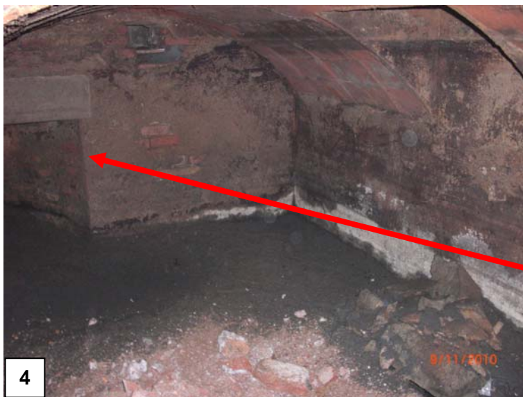
Imatge:Interior col·lector, al costat esquerra es pot veure l'obertura corresponent a la canalització que desguassa. Imatge dreta: detall obertura canal de desguàs al col·lector. Autora: Marta Maragall
