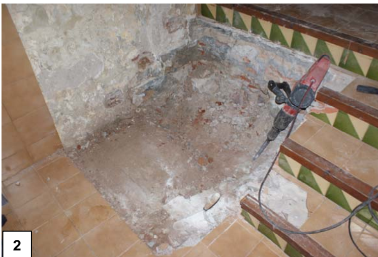
Imatge: localització i ubicació de la fossa per a la caixa d'ascensor just en l'inici de les escales que duen als pisos superiors.
